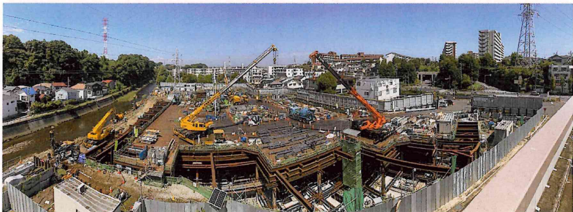
全景（令和 6 年 9 月）
