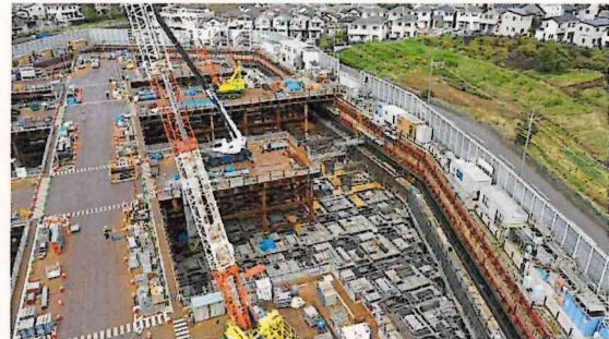
躯体構築工（令和 6 年 9 月）
