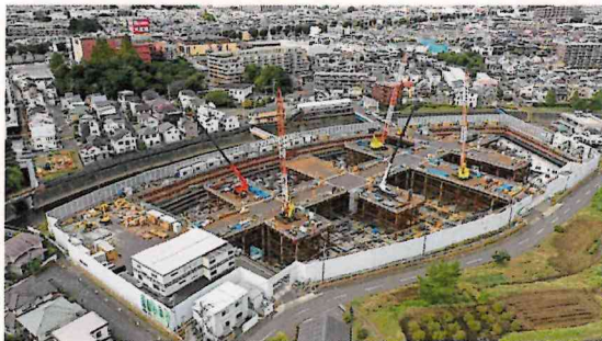
全景（令和 6 年 9 月）
