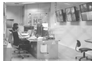
(株)クレハ環境の焼却炉中央 制御室見学
