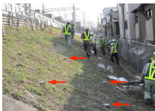
図-7 「排水パイプの設置例」
